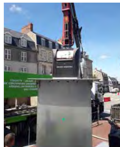
Lavage colonnes enterrées – ville de Guéret
